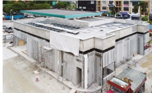
PS Jalan Reko Kajang for Petronas
